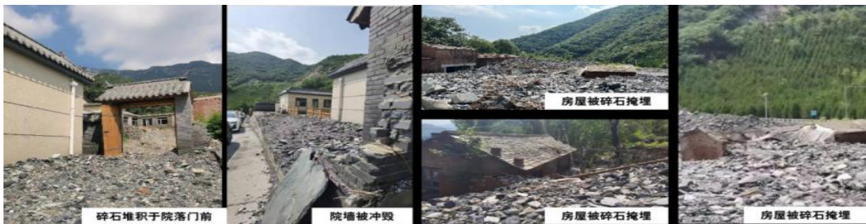
部分房屋受灾情况
