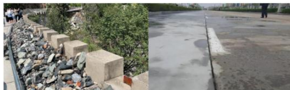
挡墙及时恢复, 消除安全隐患, 保障道路畅通
