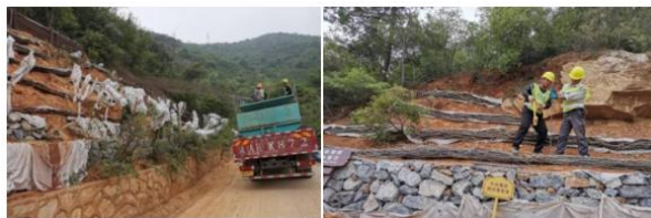
受损护坡和泄洪沟修复现场施工图
