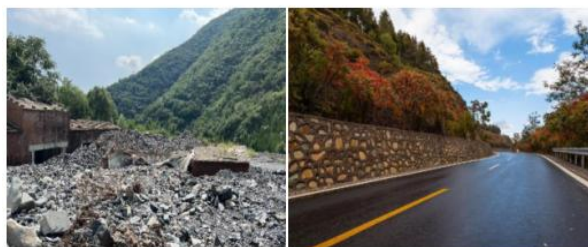
道路边坡、山体滑坡掩埋路旁建筑物采取多种形式加固边坡, 减少灾害损失
