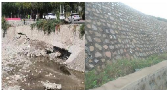
路基挡墙、河流拐弯处冲击大路基冲毁, 双层基础加强底部抗冲刷能力
